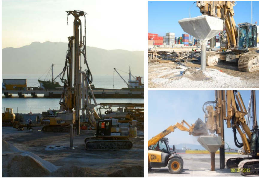
Şekil 3. Impact Sistemi ile Darbeli Kırmataş Kolon İmalatı
