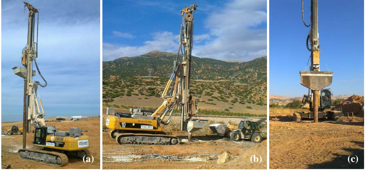
Şekil 2. Impact Sistemi ile Kolon İmalatı
