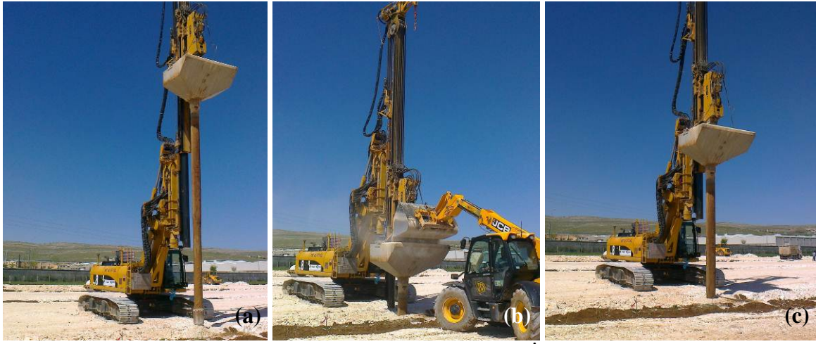
Şekil 1. Impact Sistemi ile Kolon İmalatı
