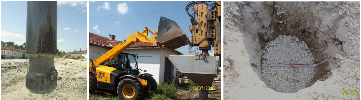
Şekil 4. Impact® Sistemi ile darbeli kırmataş kolon imalatı (Kurt, 2011)
