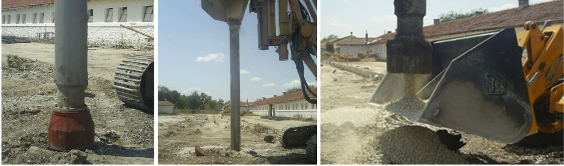
Şekil 5. Öteleme sistemi ile taş kolon imalatı (Kurt, 2011)
