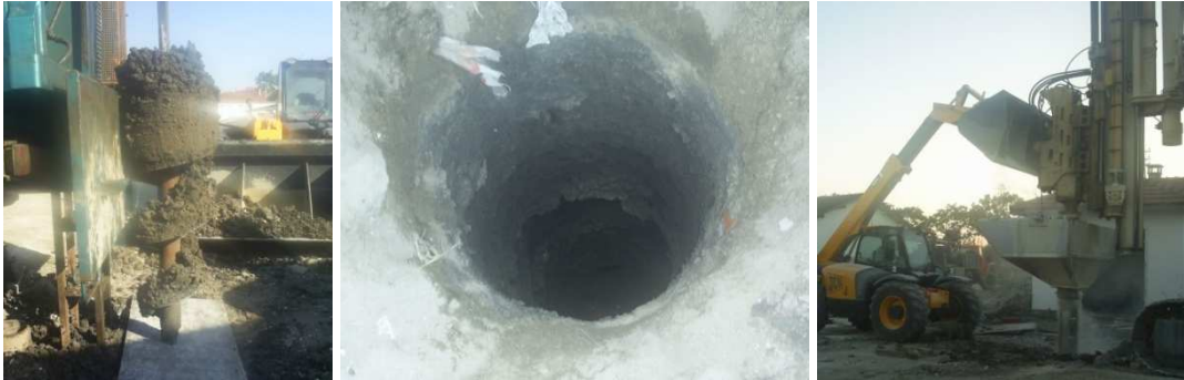
Şekil 6. Ön delgi sistemi ile taş kolon imalatı (Kurt, 2011)
