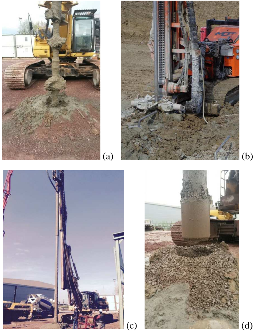
Şekil 4. Test kolonları imalatından görüntüler a) DSM b) JG c) GCC d) GIP imalatları
